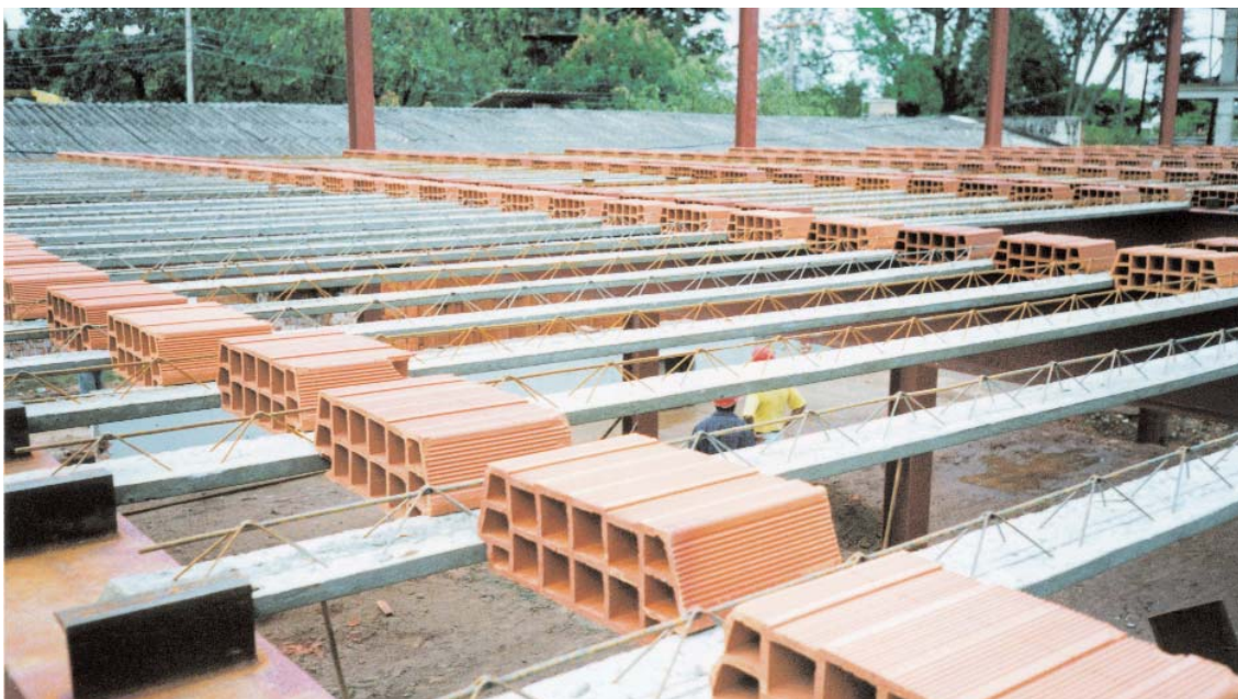
Laje com vigotas treliçadas e blocos cerâmicos.
