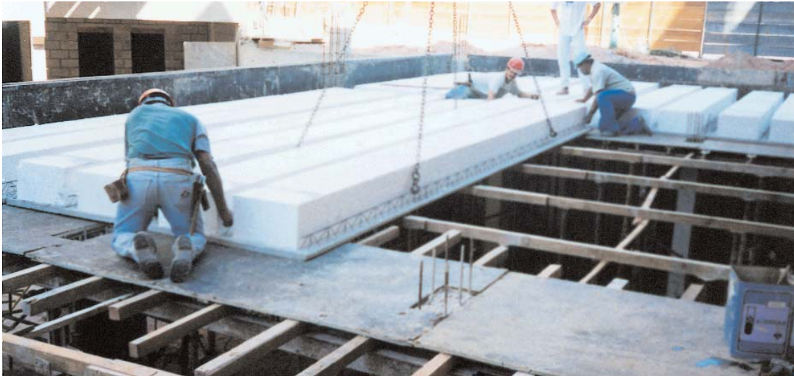
Montagem simples e rápida com pré-lajes de 1,25 m sob blocos de EPS (Condomínio Residencial em Campinas).
