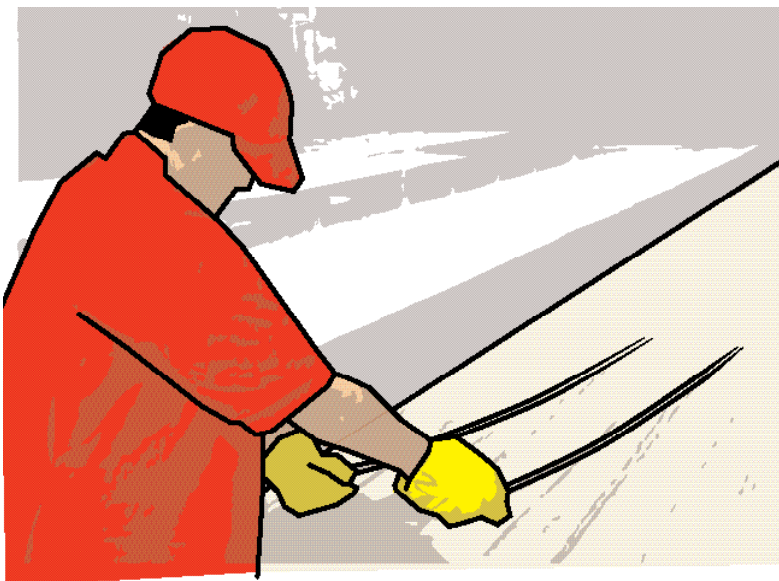
Colocação e posicionamento da armadura adicional.
