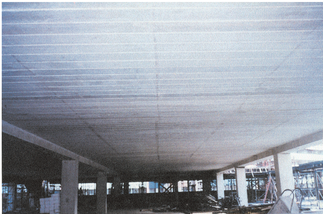
Shopping Center da Tijuca, Rio de Janeiro, Pré-laje 25 Treliçada com EPS.
