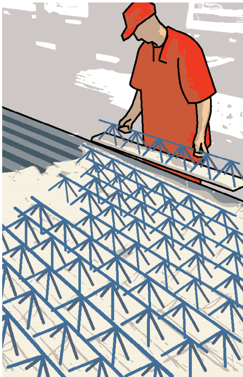
A desforma das vigotas pode ser feita manualmente.
