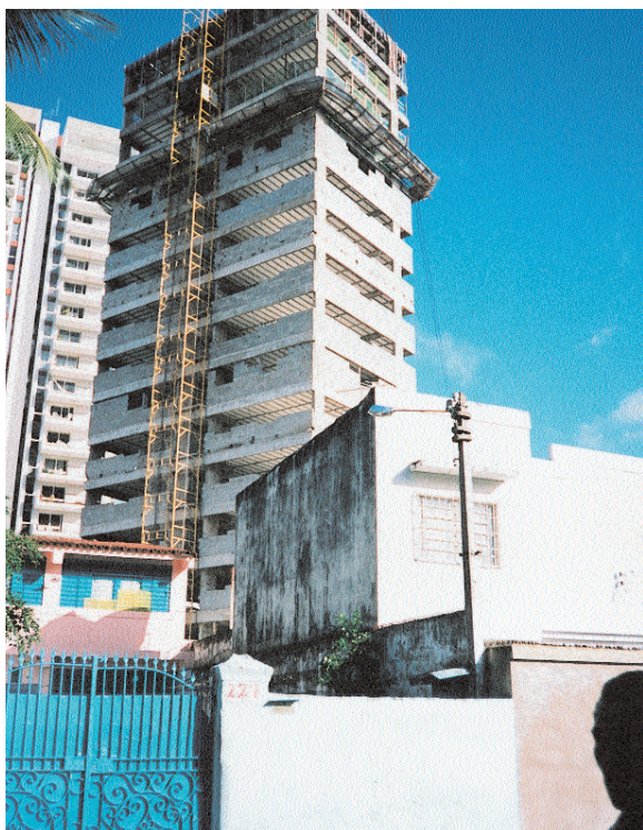
Edifício Comercial, Laje Trelaçada com EPS e Nervuras de Travamento.
