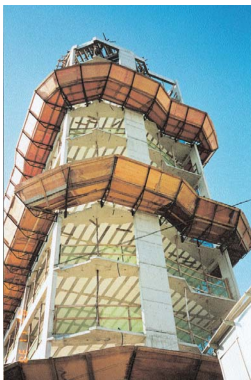
Edifício Comercial, Laje Trelaçada com EPS, estrutura plana (vigas embutidas na laje).
