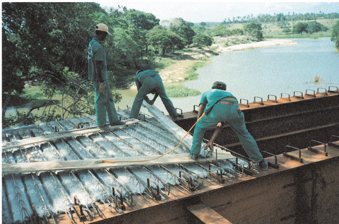
Linha Verde, 16 pontes ligando Bahia e Sergipe, Pré-laje Treliçada 25 Autoportante.
