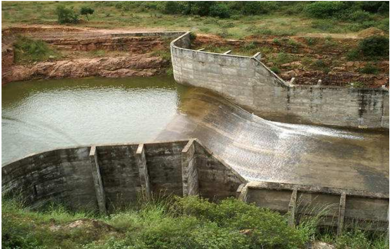
Figura X - Sangradouro – Barragem de Bocainas
