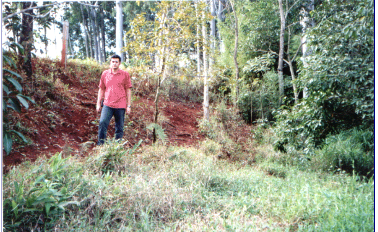
Figura IV.1.4- Erosão no talude causada pelas águas vindas da crista.
