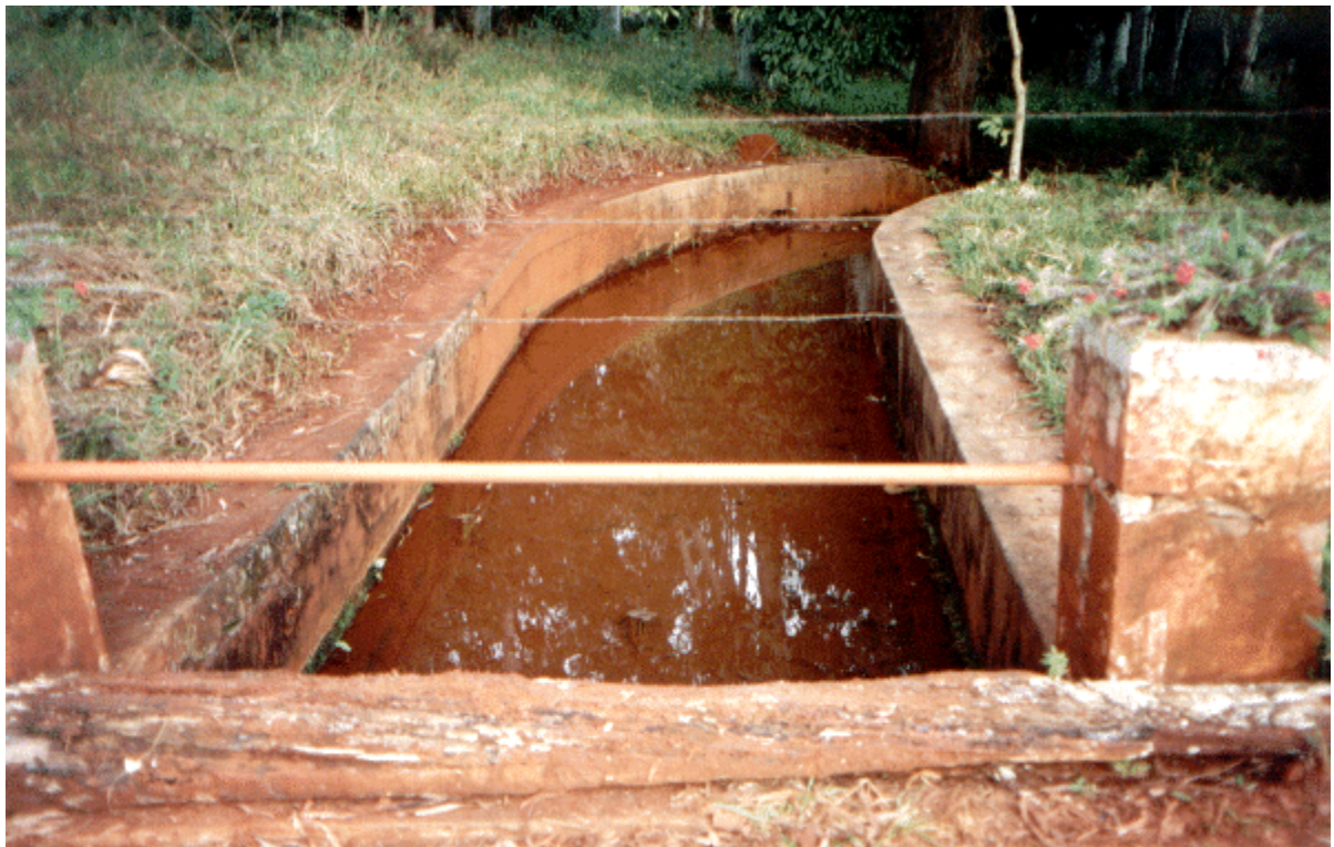
Sangradouro de Pequena Barragem
