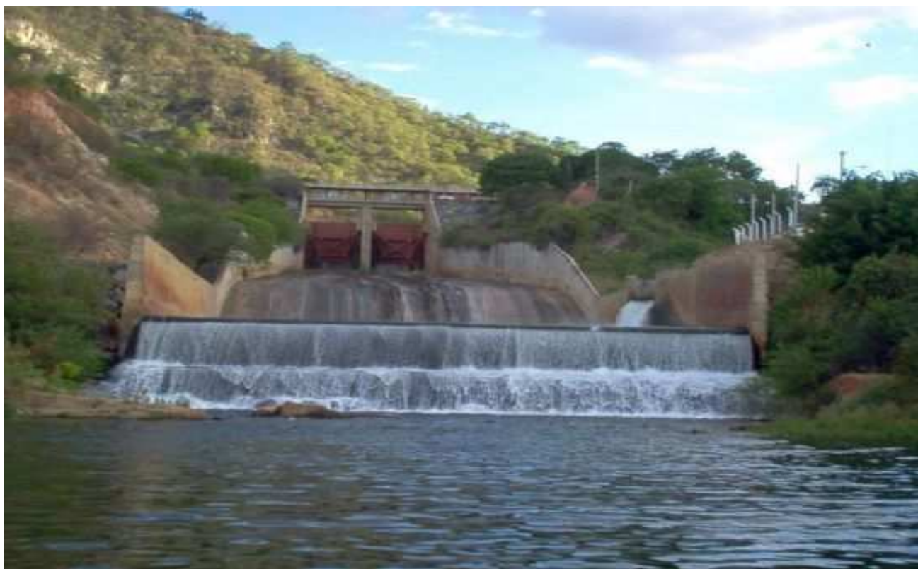
Figura X – Comportas – Barragem Engenheiro Ávido
