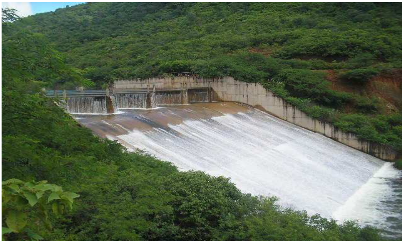
Figura X – Sangradouro – Barragem de Nova Olinda
