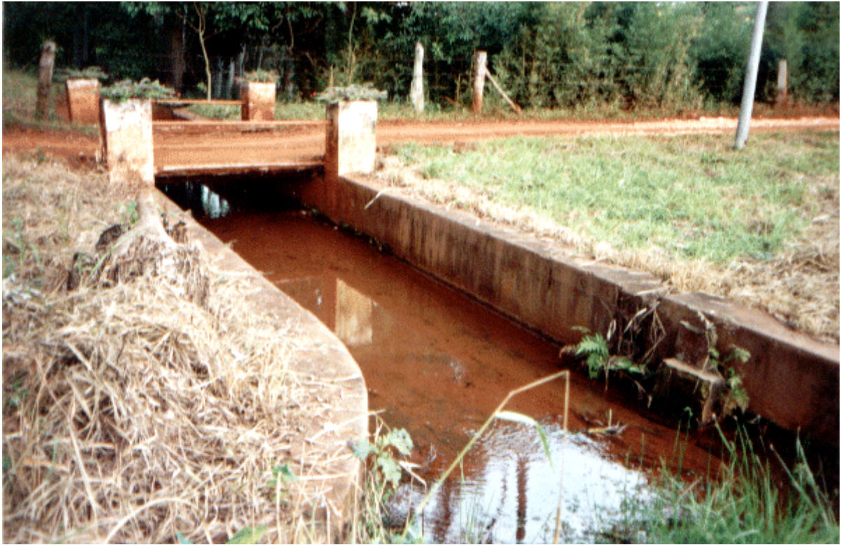
Sangradouro de Pequena Barragem
