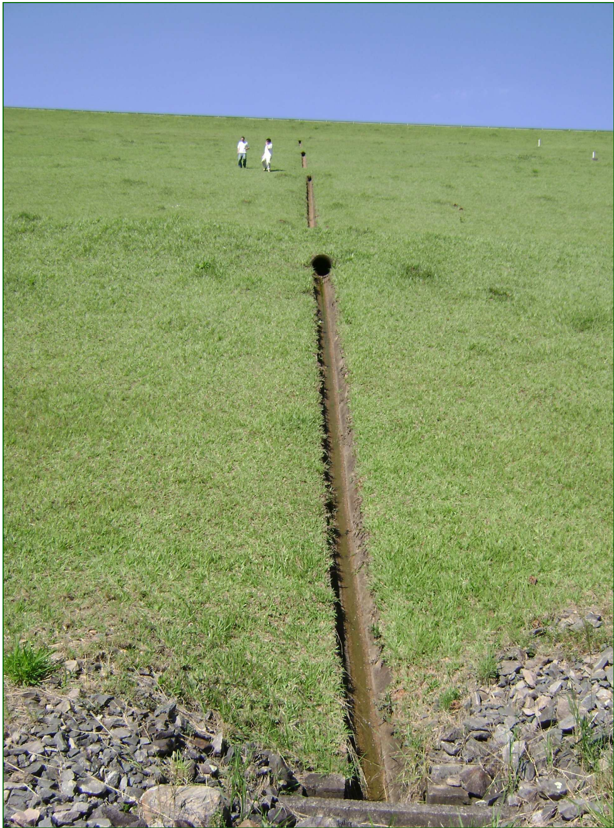
Figura IV.1.5- Sistema de drenagem nos taludes.
