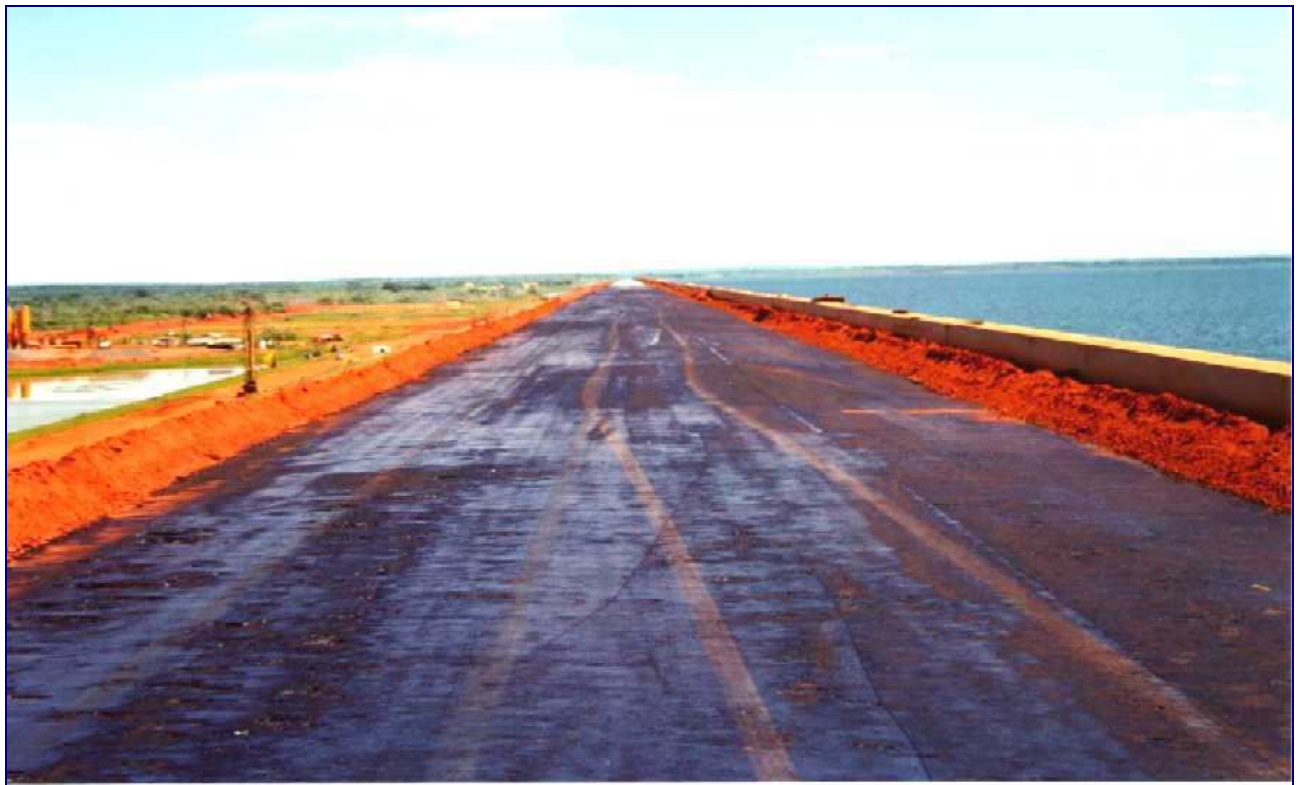
Figura IV.1.3 – Construção do pavimento da crista de uma barragem.
