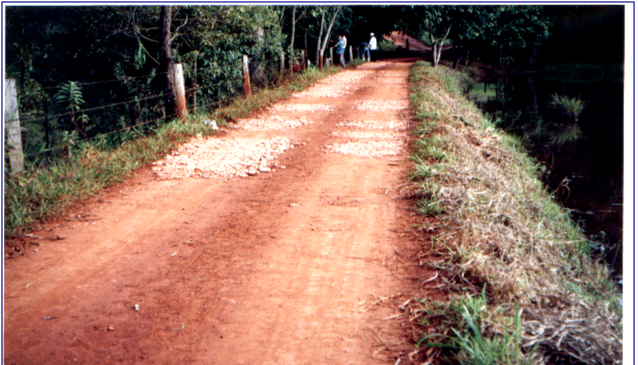
Figura IV.1-1 – Crista de uma barragem de terra.
