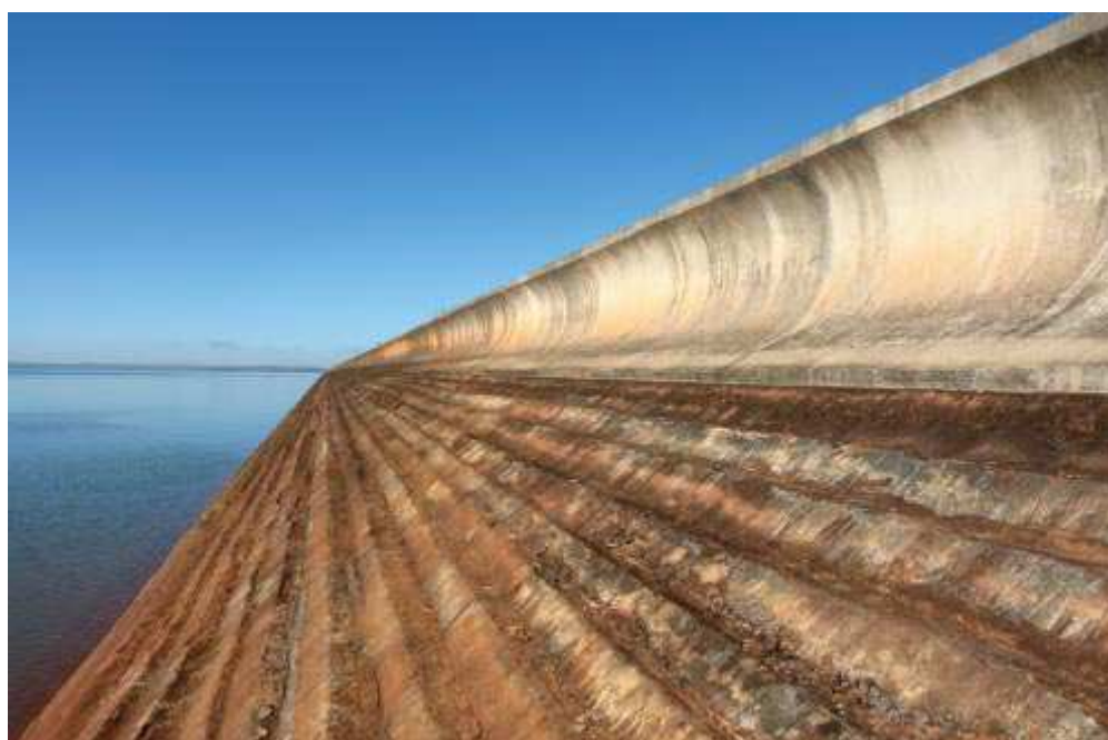
Figura IV.2.1- Soil-cement Protection and Wave Deflector Concrete Wall - Barragem de Porto Primavera
