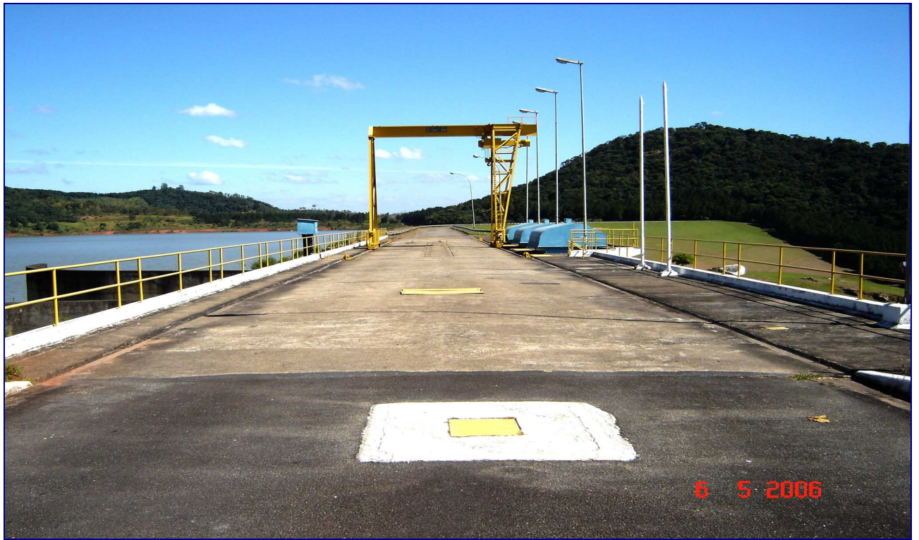
Figura IV.1-2 – Crista de uma barragem de terra.
