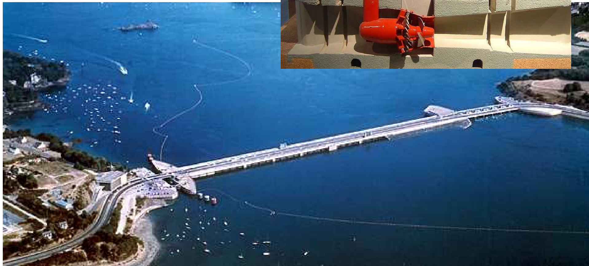
Usinas maré motrizes: La Rance Barrage, France. A barragem tem 740m de comprimento e está equipada com 24 turbinas de fluxo duplo, cada uma com 10 MW de potência.
