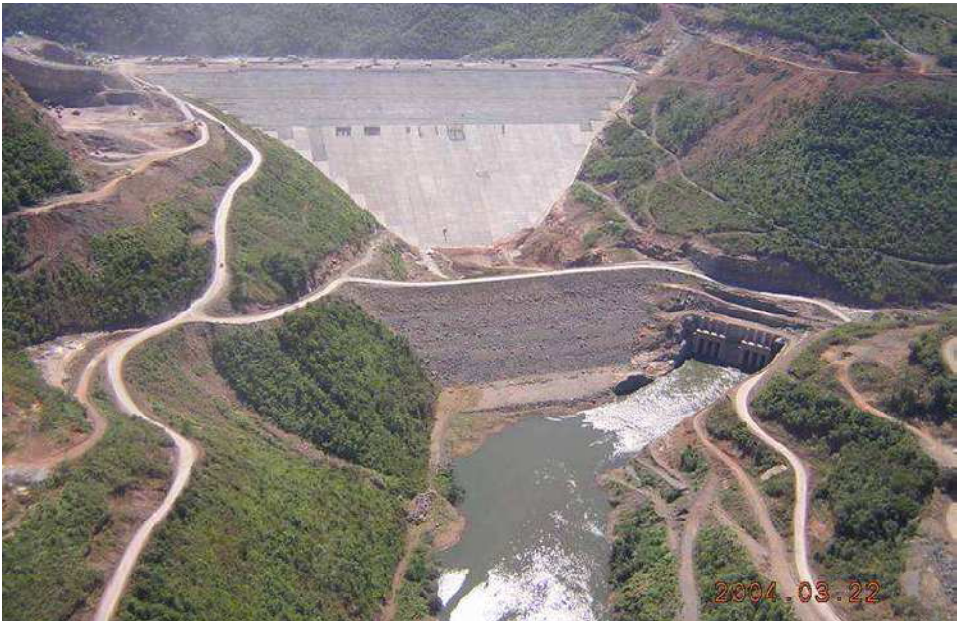
Face de concreto: UHE Barra Grande – SC/RS (690 MW), Rio Pelotas (2004)
