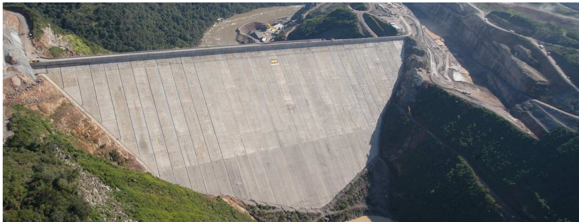
Face de concreto: UHE Campos Novos – SC (880 MW), Rio Canoas (2004)
