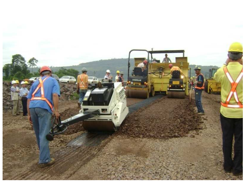
Núcleo asfáltico: UHE Foz do Chapecó – SC/RS (855 MW), Rio Uruguai (fev 2010)
