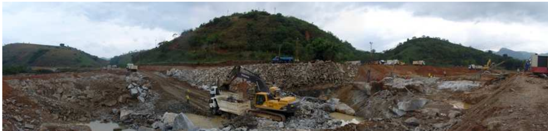
AHE Simplício – RJ/MG (333,7 MW), Rio Paraíba do Sul (nov 2007): Canal de desvio de Anta
