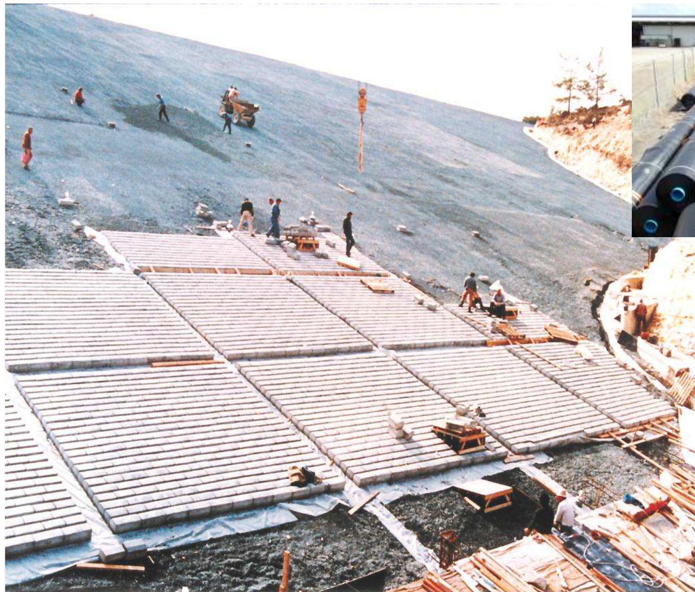
Enrocamento com face revestida em PEAD: Barragem Symvoulos, Limassol, Reino Unido. 37m de altura, 200m de comprimento e área de 10,000 m 2 com PEAD.
