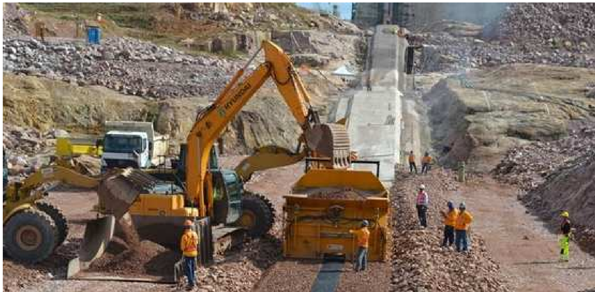
Núcleo asfáltico: UHE Jirau – RO (3750 MW), Rio Madeira
