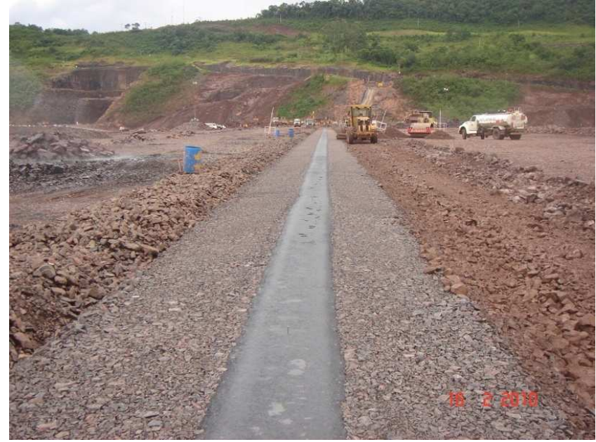
Núcleo asfáltico: UHE Foz do Chapecó – SC/RS (855 MW), Rio Uruguai (fev 2010)
