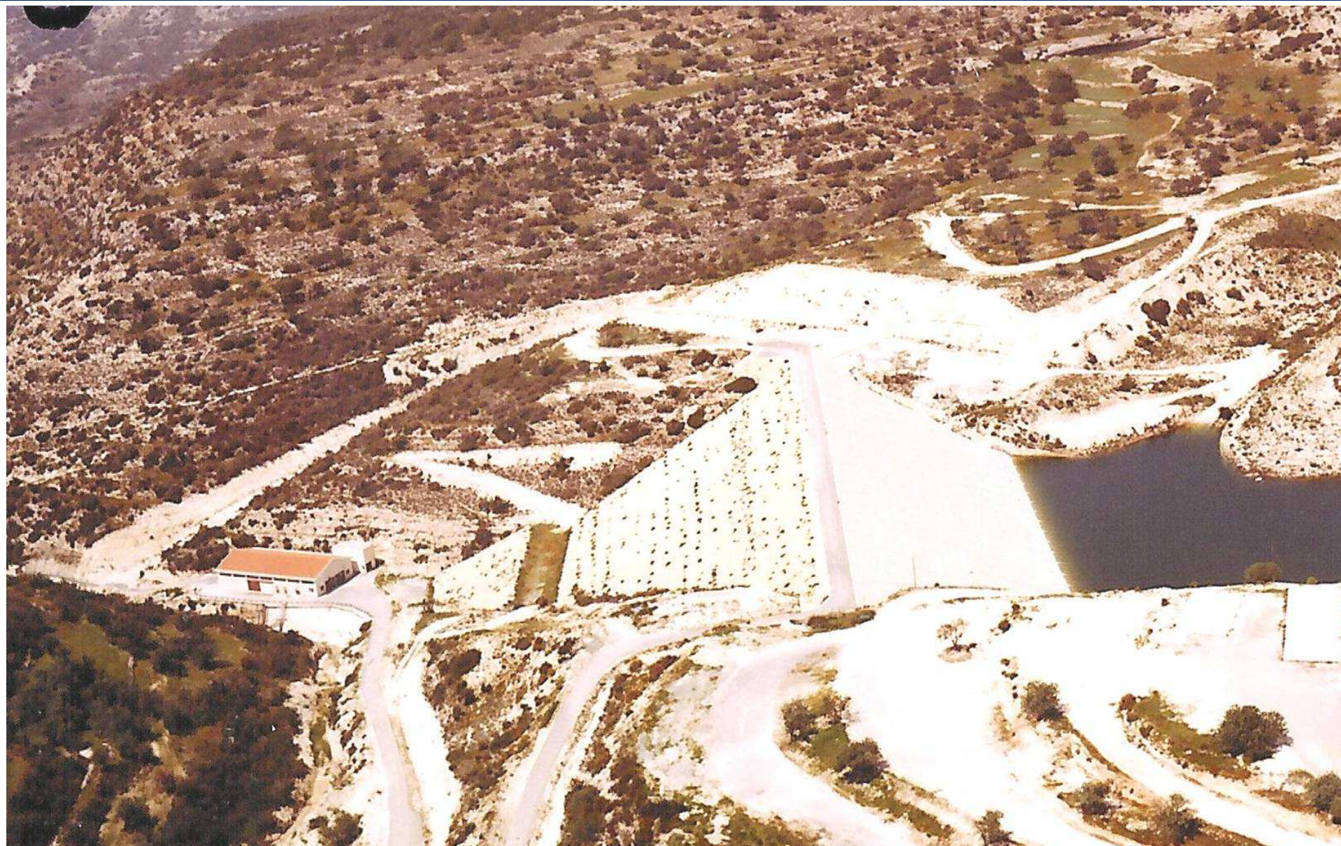
Enrocamento com face revestida em PEAD: Barragem Symvoulos, Limassol, Reino Unido. 37m de altura, 200m de comprimento e área de 10,000 m 2 com PEAD.
