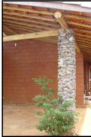
Figura 11: Vista parcial de parede de adobe em uma residência da Ecovila Santa Branca Foto: Mayara Cruvinel de Oliveira
