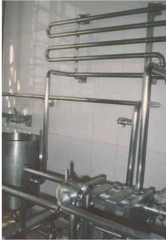
Figura 15 – Foto do pasteurizador de placas.
