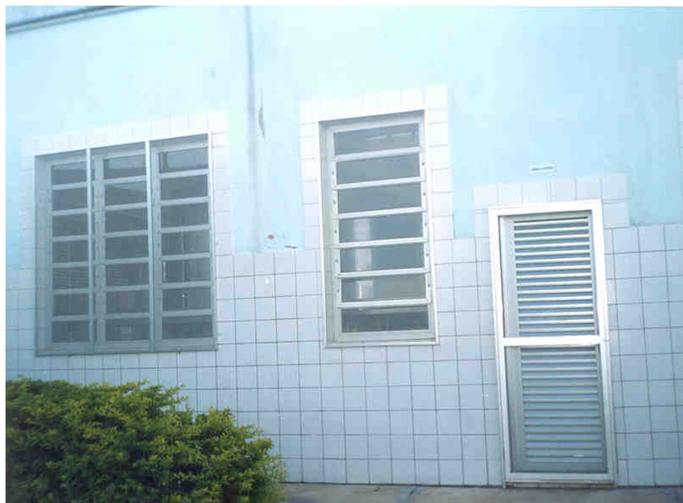
Figura 1 – Foto das portas e janelas do laticínio com telas
