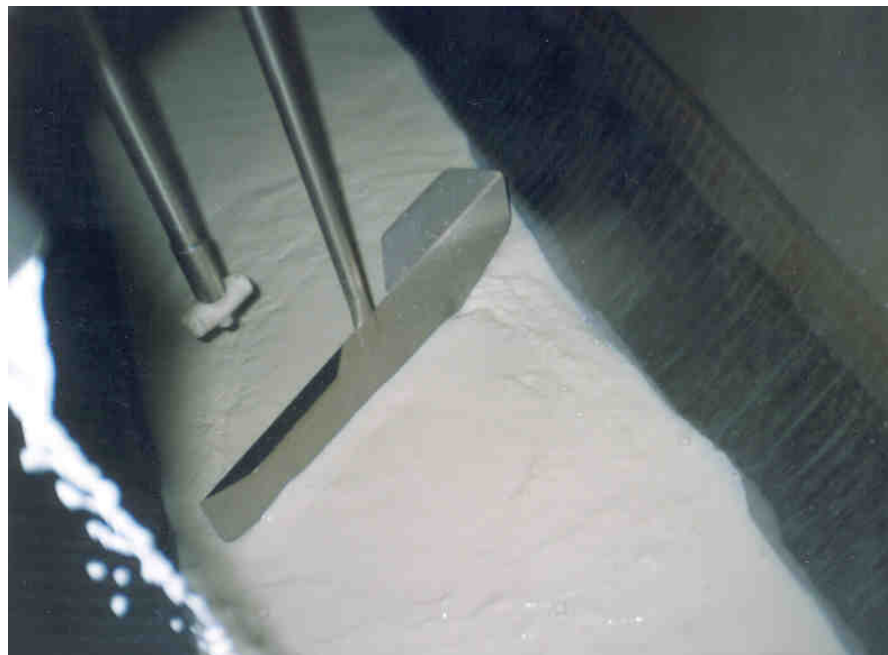
Figura 13 – Foto interior do tanque de expansão
