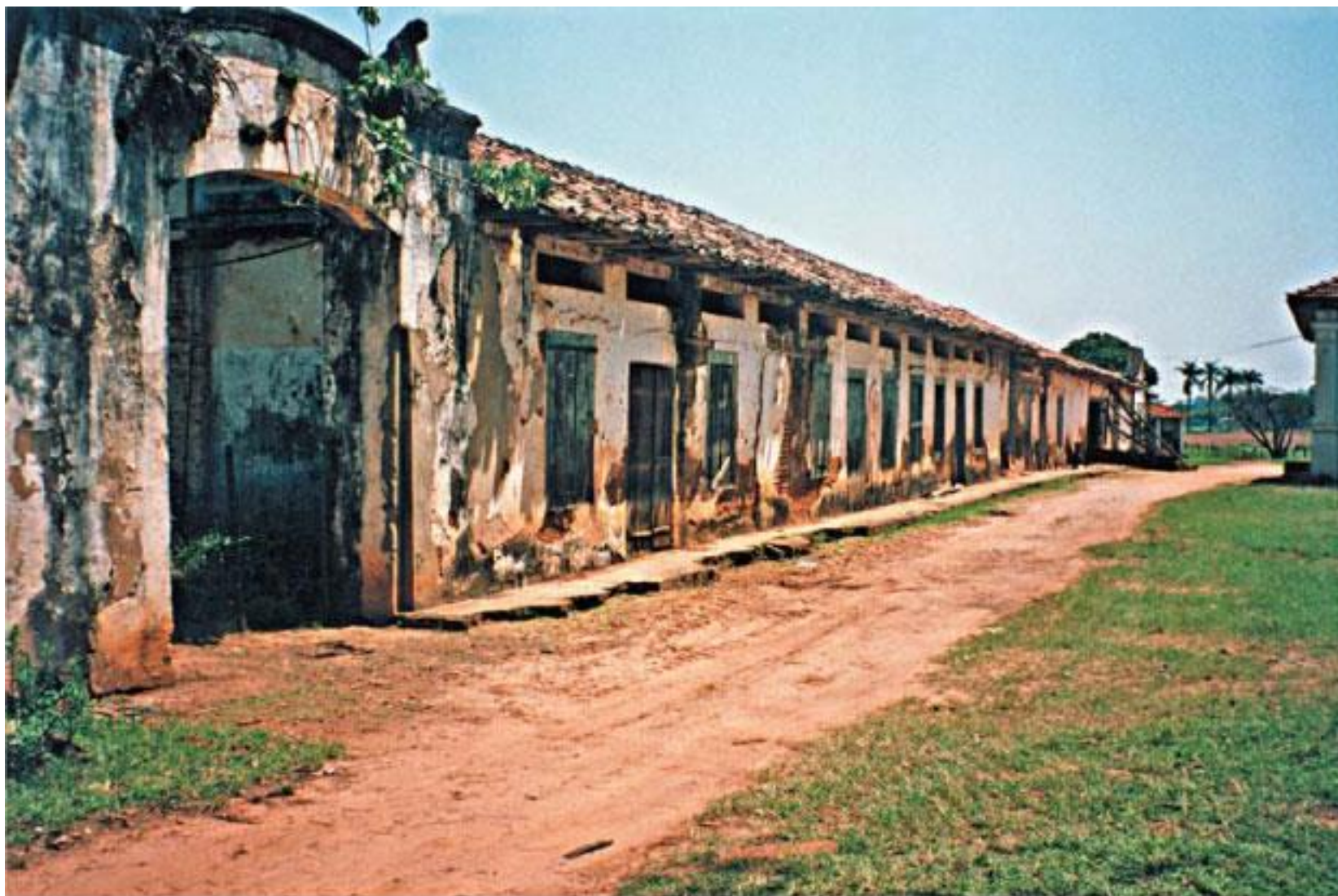
Figura 29 – Fazenda Pau d’Alho. Senzala da fazenda de café erguida na segunda metade do século XIX. Segmento da parede do curro onde ficava a porta de entrada. Erguida em taipa de pilão com divisórias em taipa de mão. Fotografias da equipe.
